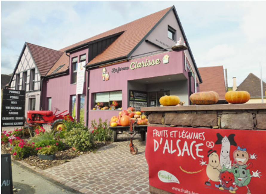
An der Ortsdurchfahrt in Sigolsheim im Elsass bauten die Betriebsleiterinnen einen neuen Hofladen samt Restaurant und Verarbeitungsräumen.
